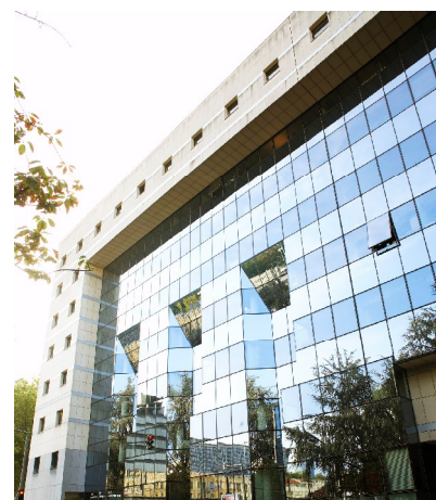
Lyon 3 ème , 228 rue Garibaldi 2 890 m 2
