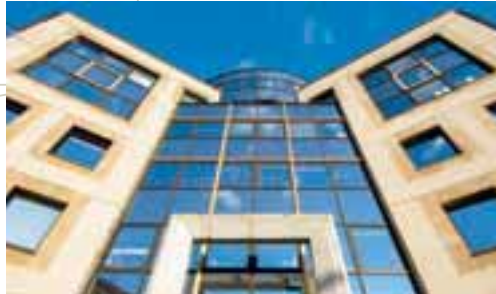
IMMEUBLE DE BUREAUX_ ISSY-LES-MOULINEAUX (92).
