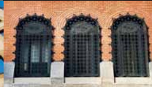
IMMEUBLE FRANCE TÉLÉCOM_PARIS (75).
