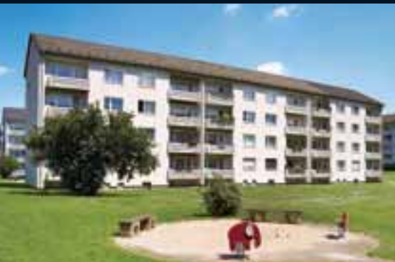
IMMEUBLE DE LOGEMENTS HÖLDERLINSTRASSE_DUISBURG, ALLEMAGNE.
